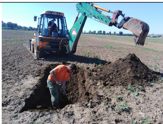
Obrázek č.9 Bagrovaná sonda dozorovaná pyrotechnikem
